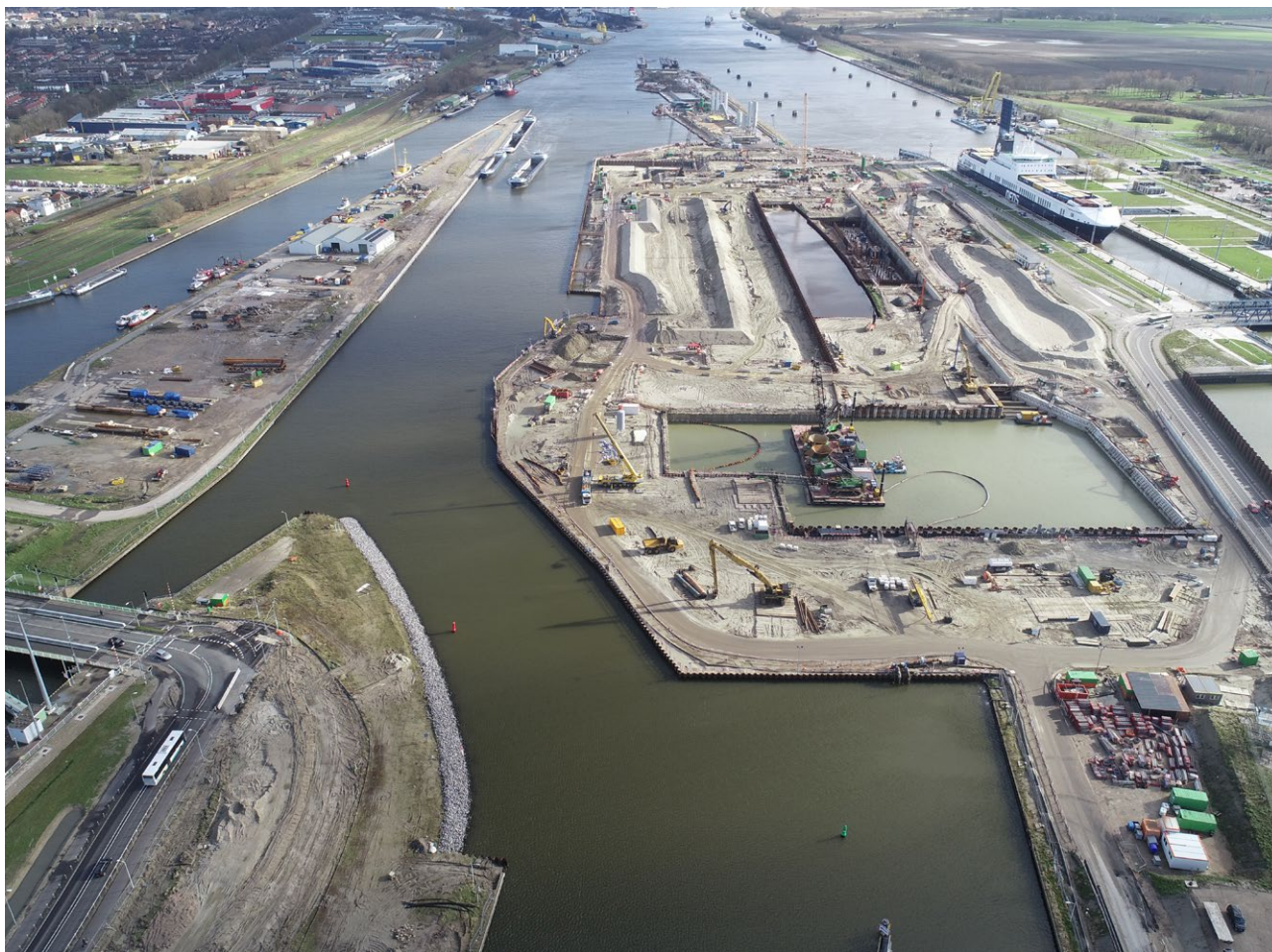
Project Nieuwe Sluis Terneuzen: zicht op de bouwput van het buitenhoofd. Deze wordt nat ontgraven, leeggepompt en dan wordt beton gestort. In de inham aan de linkerkant komen straks twee deurkassen voor de enorme deuren. Een stukje van de kolk is zichtbaar; dat is een bouwput waar de bodemroosters worden voorzien voor het nivelleren. De sluis kolk zal met onderwaterbeton worden gerealiseerd. Het kanaal aan de linkerkant is een tijdelijk gegraven doorvaartkanaal, waardoor de scheepvaart nog steeds van drie sluisen gebruik kan maken
